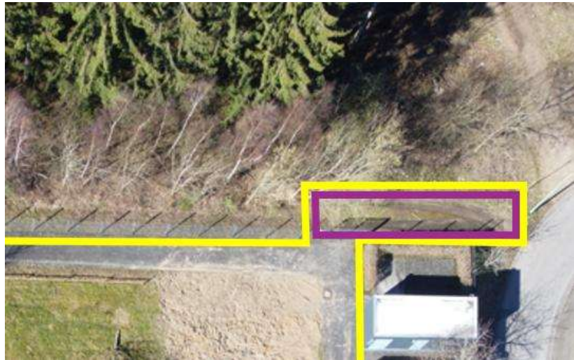
Fläche im Kurvenbereich des Uelenbender Wegs, Blick von Osten
